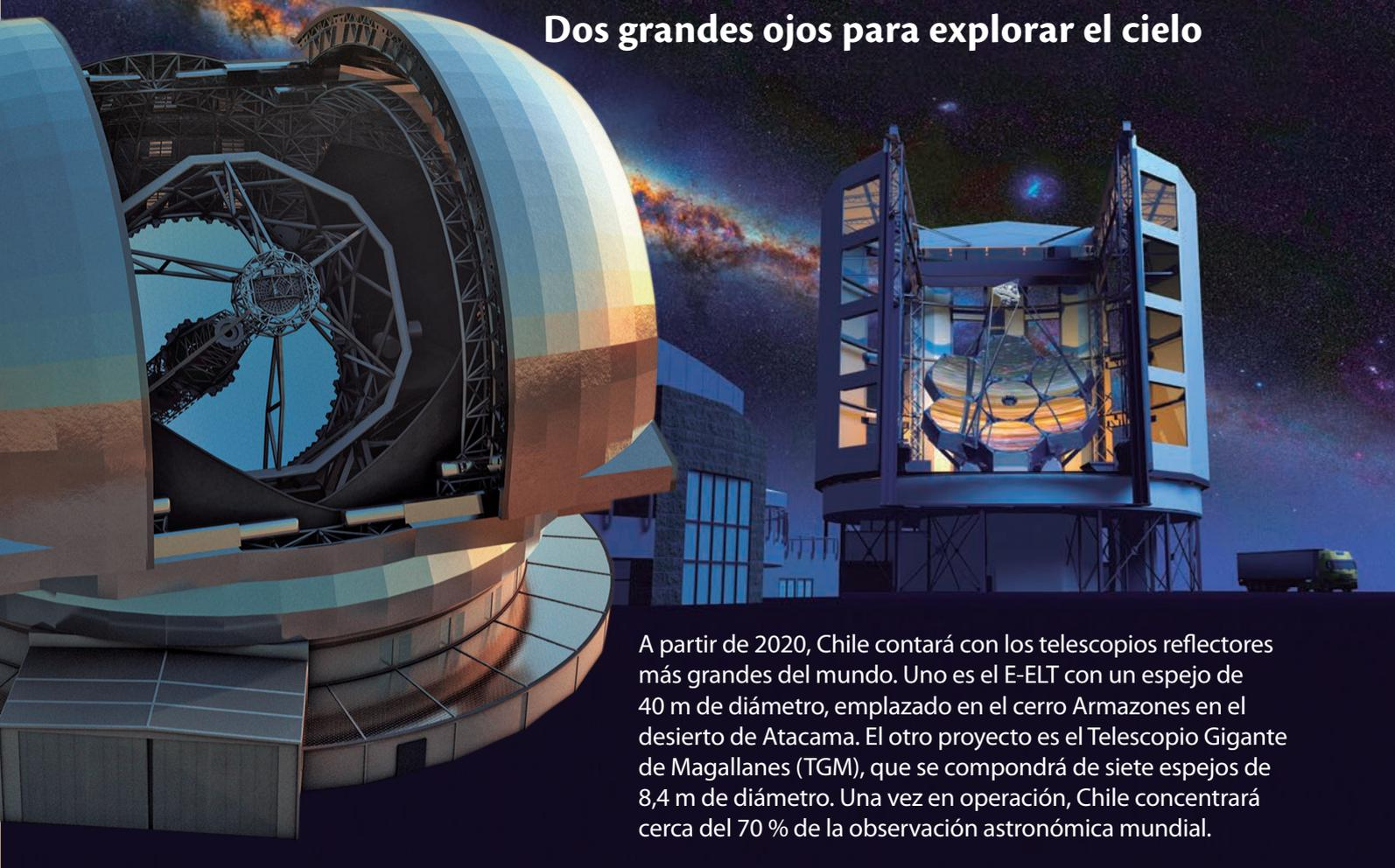
A partir de 2020, Chile contará con los telescopios reflectores más grandes del mundo. Uno es el E-ELT con un espejo de 40 m de diámetro, emplazado en el cerro Armazones en el desierto de Atacama. El otro proyecto es el Telescopio Gigante de Magallanes (TGM), que se compondrá de siete espejos de 8,4 m de diámetro. Una vez en operación, Chile concentrará cerca del 70 % de la observación astronómica mundial.
